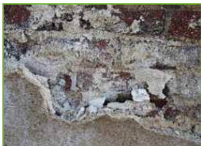
Типичные повреждения в результате солевых отложений
